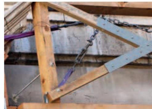
[18] Palazzo Comunale di Nizza, dettaglio dei tasselli chimici, di lunghezza L (mm) 1000, realizzati in acciaio inox, a estremità filettata con passo M6 ISO normalizzato e fissati nella loro parte finale con un dado e una rondella.
